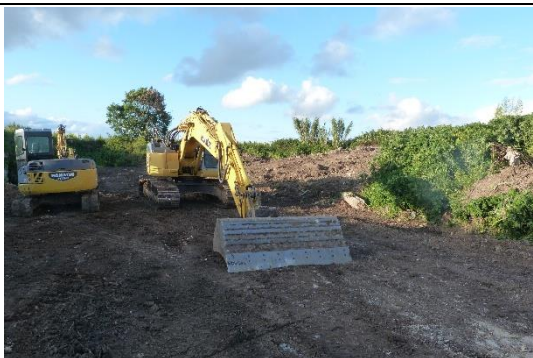
Figure 7 : Le site lors de la phase de remise en état
