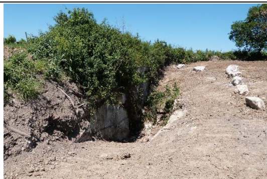
Figure 8 : Le site après remise en état
